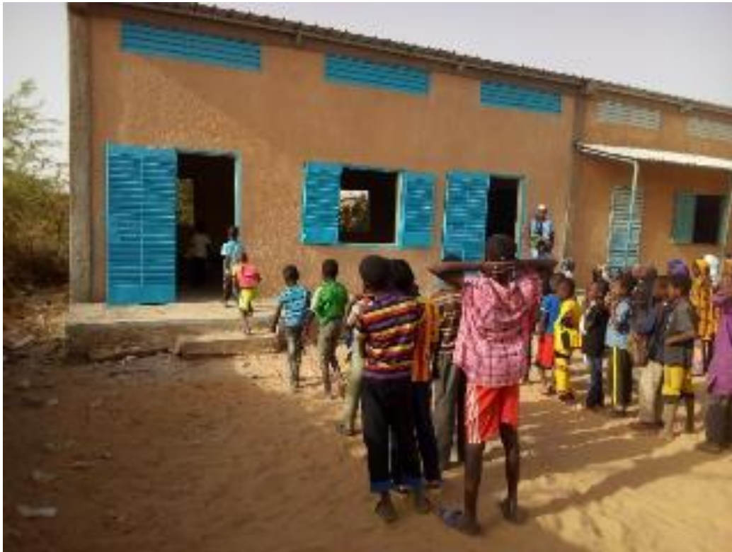
Travaux de finition de la classe
